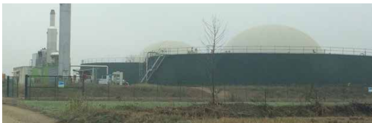
Impianto di produzione del biogas
